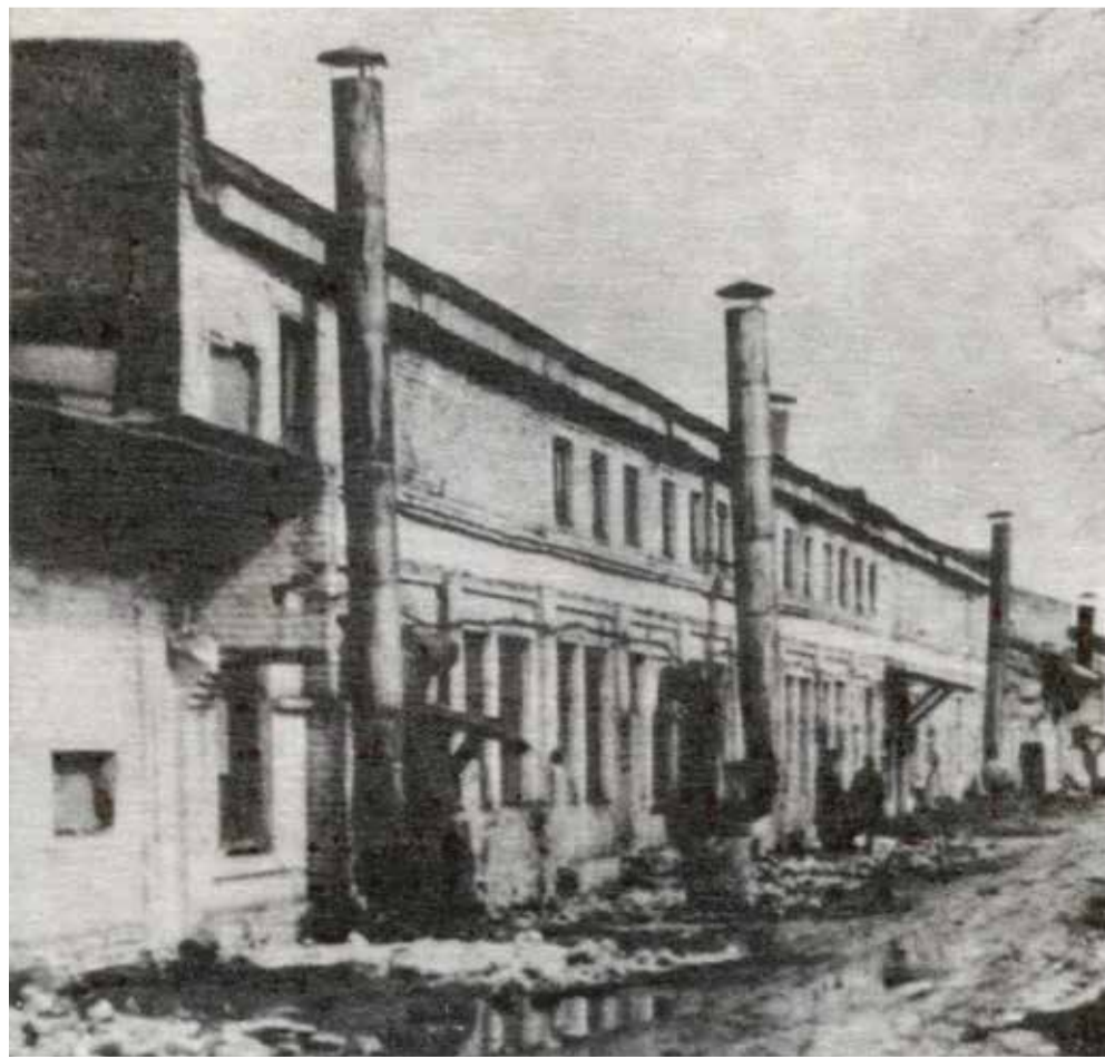
Производственный корпус в Бердске
